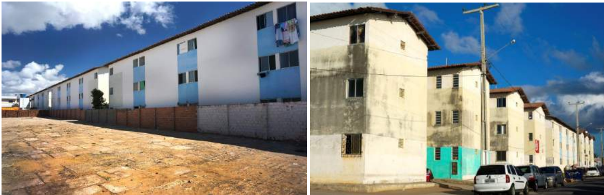
Figura 104: Edifícios multifamiliares do Programa de Arrendamento Residencial (PAR), em Maceió-AL. Fonte: Adolphe, 2013).
